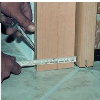
Achten Sie bei der Montage auf den richtigen Abstand von Futter und Blatt. Zur Fixierung der Montagewiseite ziehen Sie die Schrauben sodann fest an.
