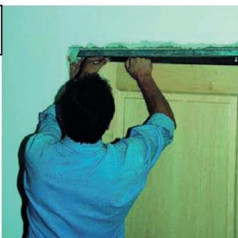
Hängen Sie das Türblatt in die obere Montagewiseite der Schiebetür ein. Die ideale Breite der Führungsnut an der Unterseite des Türblatts beträgt 8 mm.
