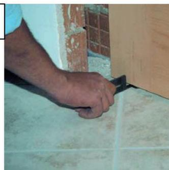
Schließen Sie die Schiebetür. Dann schieben Sie den Schiebetürgleiter von hinten (ggf. auch von vorne) in die Führungsnut an der Unterseite des Türblattes ein.
