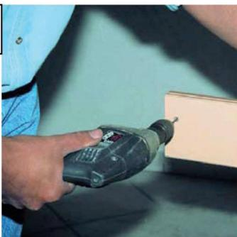
Bringen Sie an der Rückseite der beiden Futterteile des Türstocks, im Abstand von 20 mm zum Boden, jeweils eine Bohrung mit 5 mm Durchmesser an.
