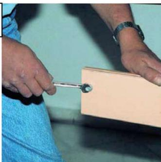
Schrauben Sie mittels eines 10er Schraubenschlüssels die Spezialschrauben mit Neopren-Scheiben leicht an.
