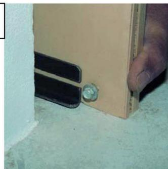
Führen Sie beide Futterteile mit den Schrauben in die stegartigen Flügel des Schiebetürgleiters ein und richten Sie diese mit je 5 mm Abstand zum Blatt aus.
